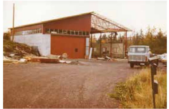
Her er produksjonen flyttet til det nye bygget på venstre side og man er igang med å sette opp den andre halvdel.
