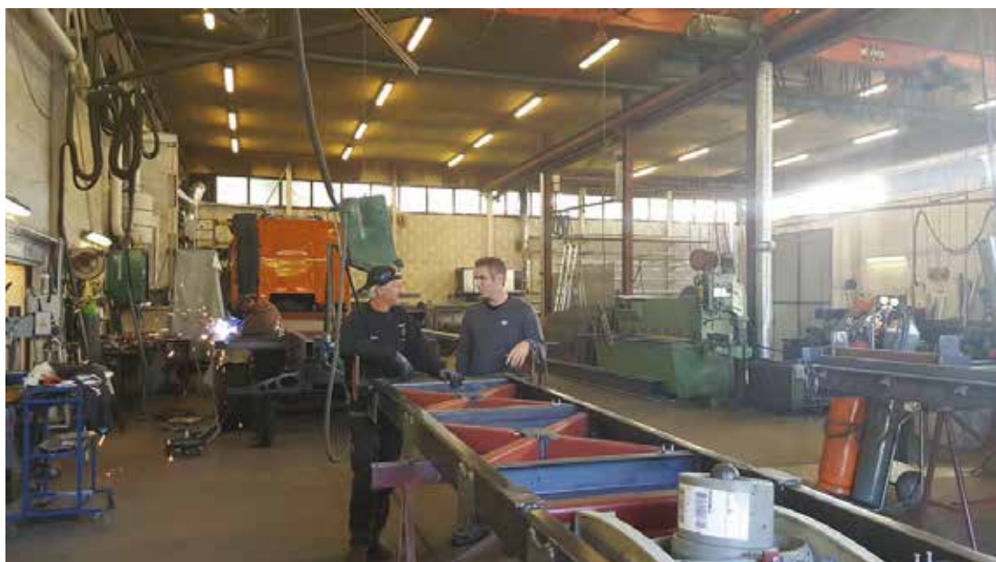
Her står til venstre, Vidar Akerholt og daglig leder Øyvind Røste i samtale ved grunnrammen til et nytt påbygg som er under bygging.
