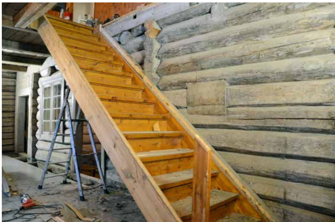
Nytt gulv og trapp ble lagt med tykke, brede bord. Legg merke til den flotte, gamle tømmerveggen som nå er blitt synlig.
