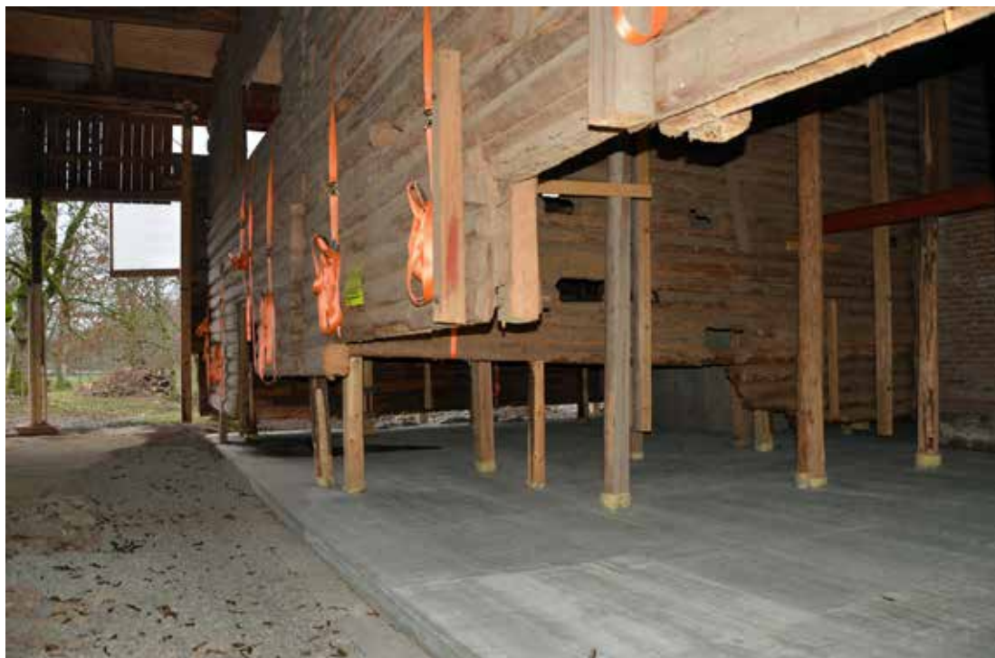
I laene er støpt nytt gulv.
