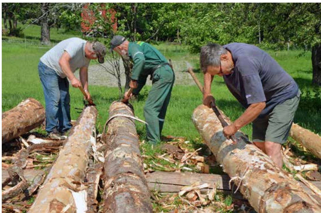
Barking av tømmer til rep. av laer i driftsbygningen.
